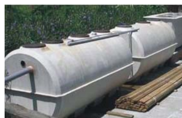
圖六、FRP 汗水處理設施
